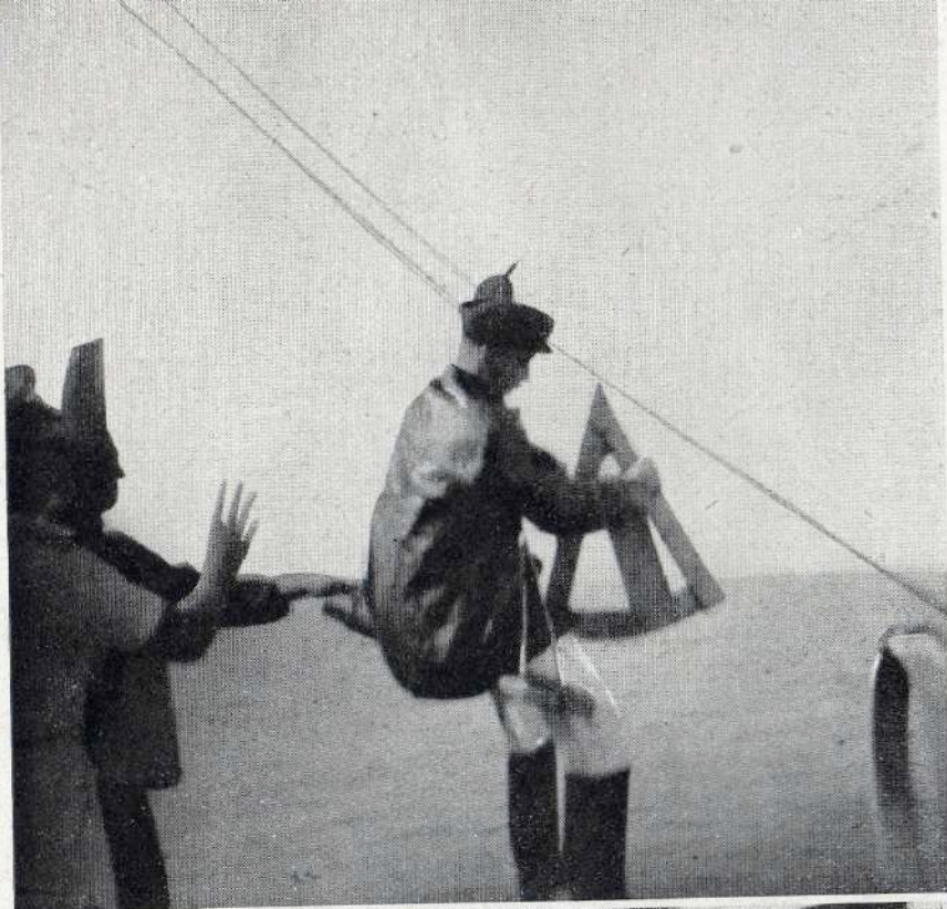
Passage de la ligne. Arrivée du pilote.
