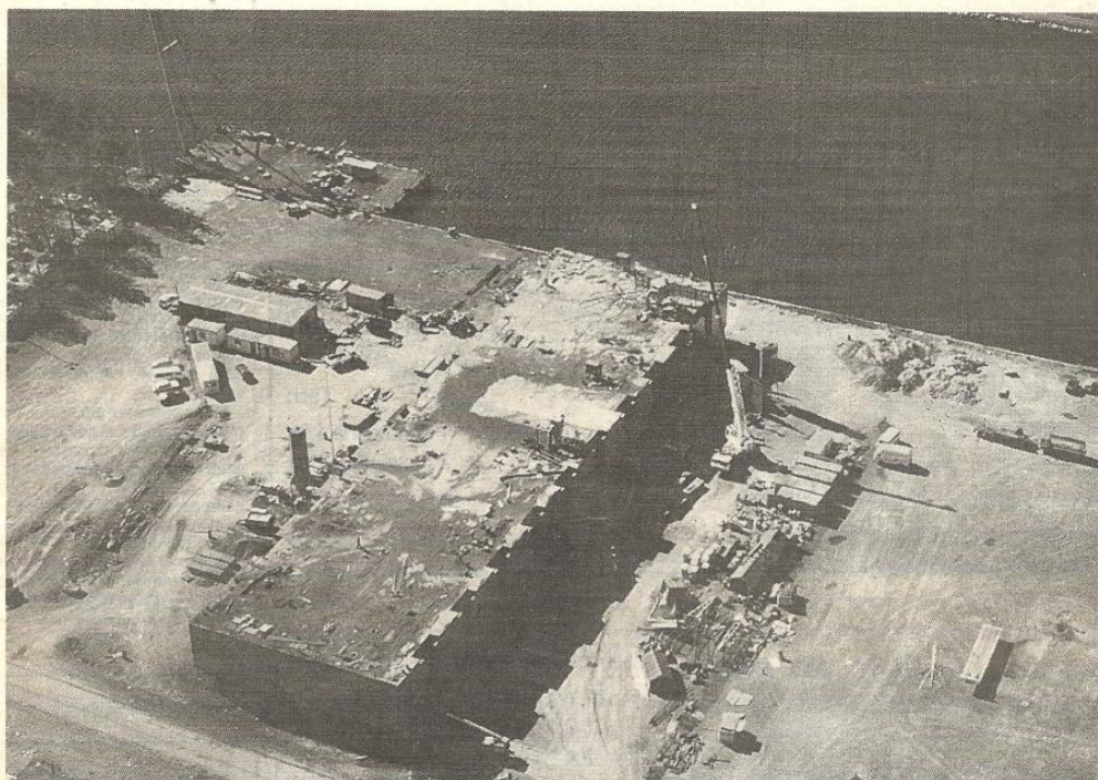
Creusée pour permettre la mise à l'eau des sous-marins de nouvelle génération, la forme Cachin devra être mise en eau pour accueillir son monte-charge géant, qui servira de barge flottante fixe au « Triomphant » et à ses frères.
