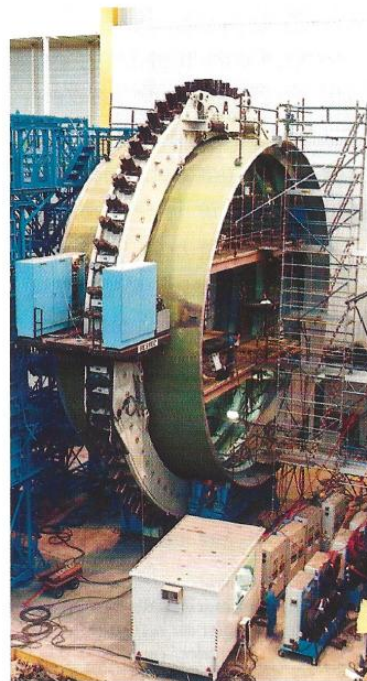
Pour un parfait nivellement des coques à assembler
