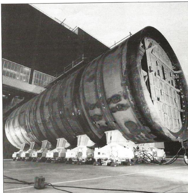
Novembre 1990 : arrivée sur marcheurs des sections 53 et 54 (1200 tonnes) dans la nef d'assemblage. (photo DCN Cherbourg).
