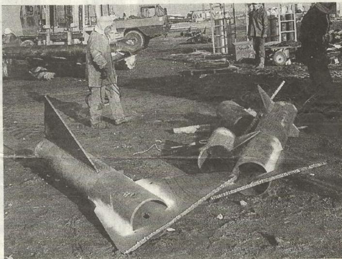
Les seafastings après leur découpage de la barge.
